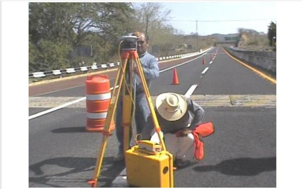
Levantamiento topográfico y control geométrico en carretera.
