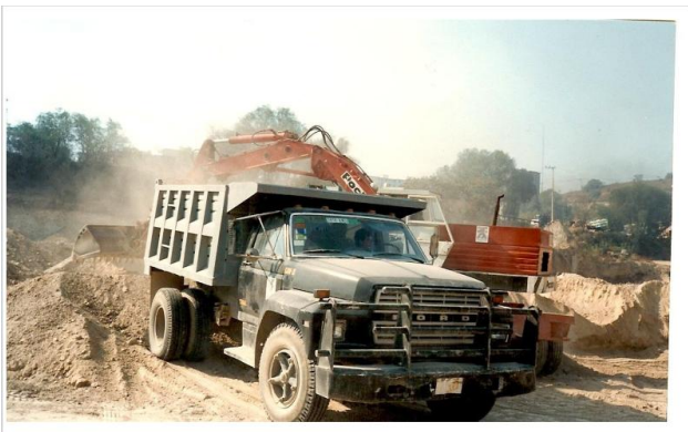
Terracerías y movimiento de materiales con maquinaria pesada.
