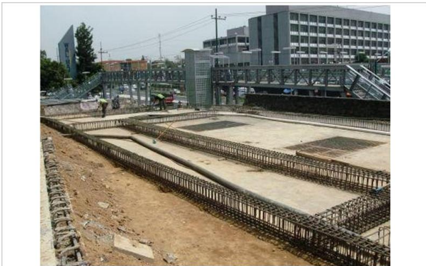
Trabajos de estructura de concreto y armado en infraestructura vial.
