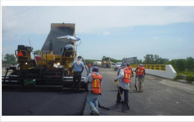
Supervisión técnica y tendido de carpeta asfáltica en vialidad.
