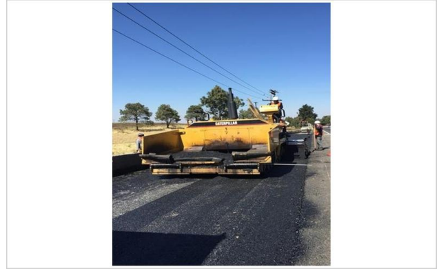
Mantenimiento y trabajos carreteros con equipo de pavimentación.
